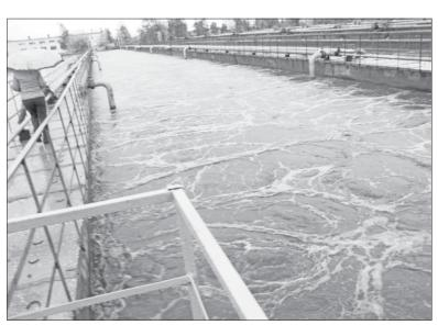
Воды проходят биологическую очистку на аэротенках, в которых воздух перемешивает сточную воду с активным илом и насыщает ее кислородом, необходимым для жизнедеятельности бактерий.
