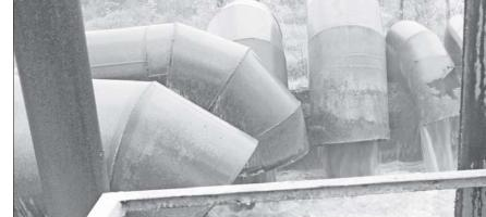
Начало начал очистных сооружений — это приемная чаша, внушительных размеров емкость, в которую по широким трубам под большим напором поступают сточные воды со всего города.
